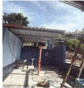
Foto 20: Instalación de soporte de metal y lámina aluzinc calibre 26 en el área frente a baños.
