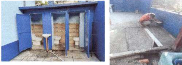
Foto 13: Reparación de planchas en losa de patio
