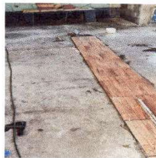
Foto 6: Sustitución de piso de cemento líquido por piso cerámico en cocina
