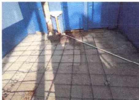
Foto 11. Instalación de lavamanos en el área de baños
