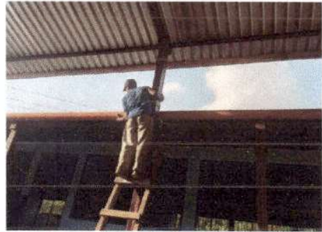
Foto 14: Sustitución de canal de PVC 3" en el establecimiento
