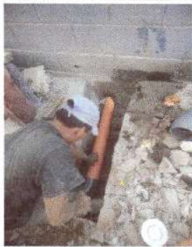
Foto 15: Sustitución de tubería PVC línea principal aguas negras y sustitución de reposadera en el establecimiento
