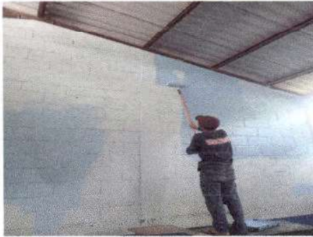
Foto 7: Pintura en muros interiores en aulas
