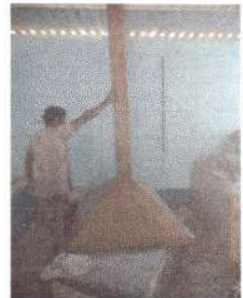
Foto 16: Sustitución de estufa rural completa incluye chimenea y plancha de metal en cocina
