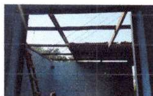
Foto 2: Sustitución de estructura de soporte de madera, por metal en la cocina
