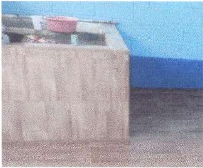
Foto 19: Sustitución de cerámico en pila en la cocina
