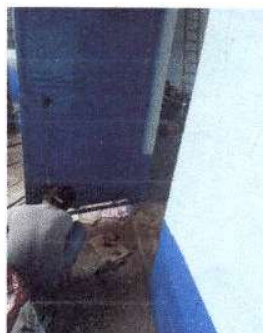
Foto 3: Mantenimiento a estructura en puertas de metal en el establecimiento.
