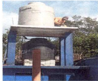
Foto 8: Impermeabilización de losa en la base del depósito de agua
