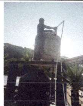
Foto 18: Sustitución de depósito de agua y sus accesorios
