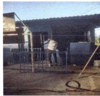
Foto 10: Fabricación e instalación de balcones de hierro en ventanas en cocina
