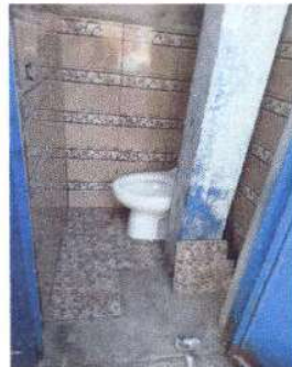
Foto 9: Sustitución de azulejo y piso cerámico en el área de baños
