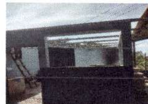
Foto 2: Sustitución de estructura de soporte de madera, por metal en la cocina
