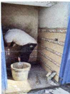
Foto 9: Sustitución de azulejo y piso cerámico en el área de baños
